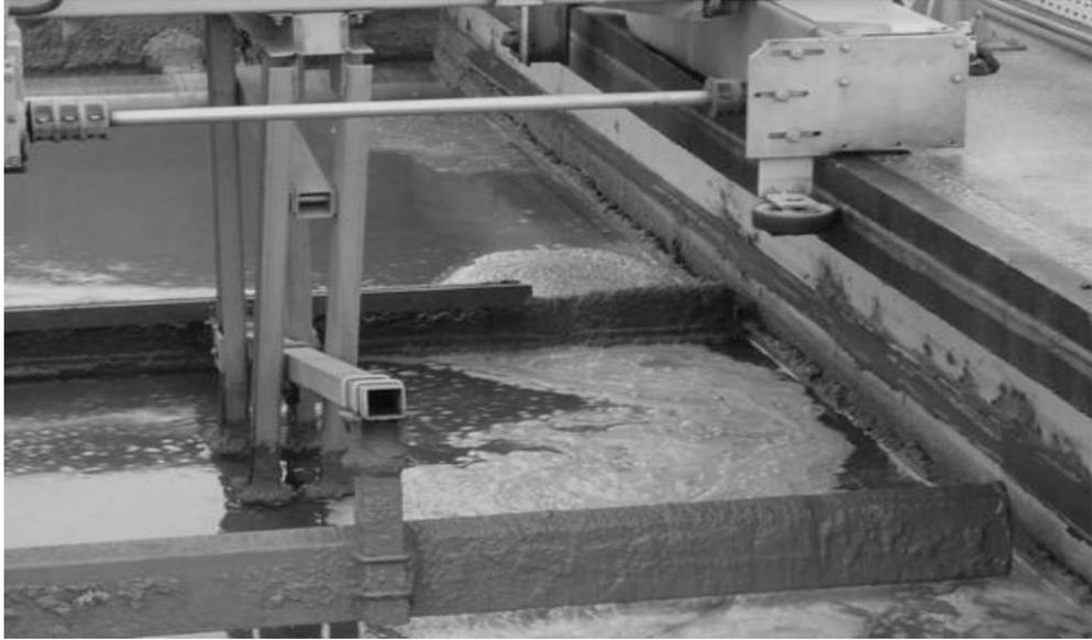
*Figure IV. 7 : Photo du déshuileur utilisé dans la station de traitement des eaux usées*
