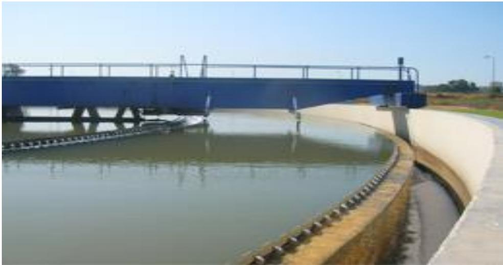
*Figure V.1 : clarificateur de la station de traitement de BARAKI*
